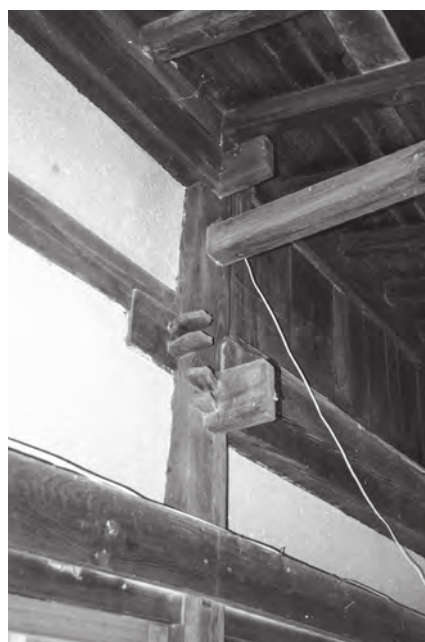
写真5 広縁側から見た胴差 (左が十帖の間)
