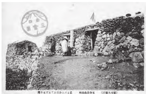
写真4 旧五合目室 入口が2ヶ所ある。中道室とも呼ばれ、御中道修行の人を泊めるため、他の室より規模が大きかったという。（富士宮市教育委員会蔵）
