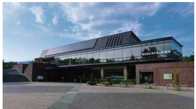
อาคารฝั่งทิศเหนือ (อาคารเก่า : ฟูจิวิชันเตอร์เซ็นเตอร์)
